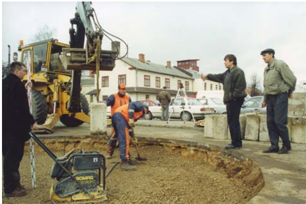
Pilsētas pulksteņa pamatu bedres rakšana Vecpilsētas laukumā 2000. gada 27. oktobrī
