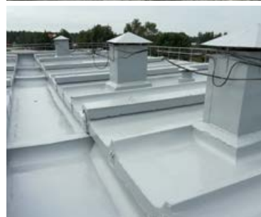
Jumta segums Celtnieku ielā 3 pirms un pēc remonta
