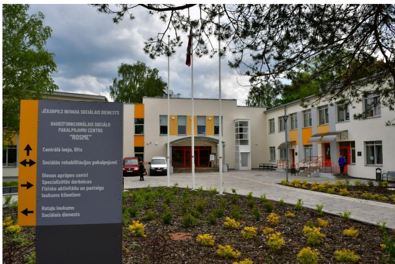
1.21. attēls Daudzfunkcionālais sociālo pakalpojumu centrs "Rosme" Jaunā ielā 39i, Jēkabpilī
