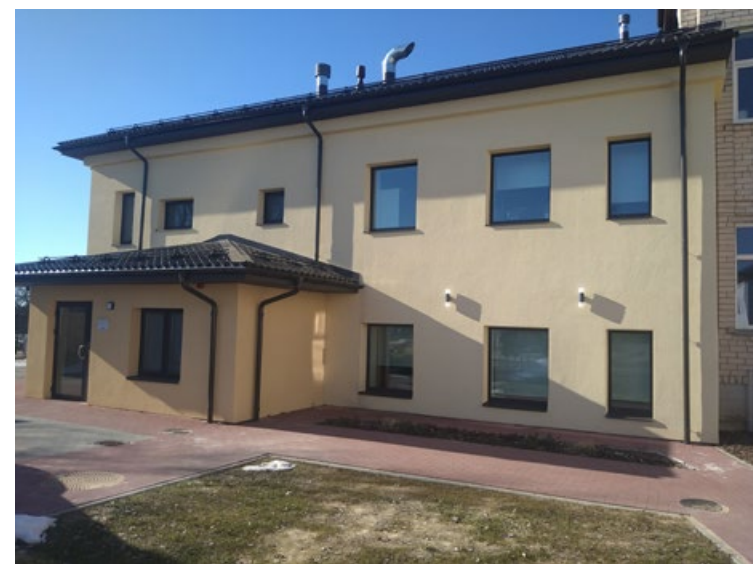
Dienas centrs un grupu dzīvokļi Skolas ielā 9, Aknīstē
